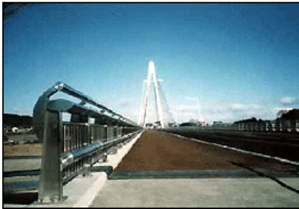
歪、キャンバー出し、曲り修正 SUS304製 製作・据付
