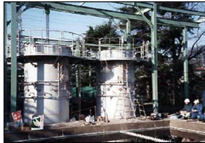
リアクター装置 SUS304製 製作・据付
